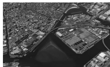
森ヶ崎水再生センター
